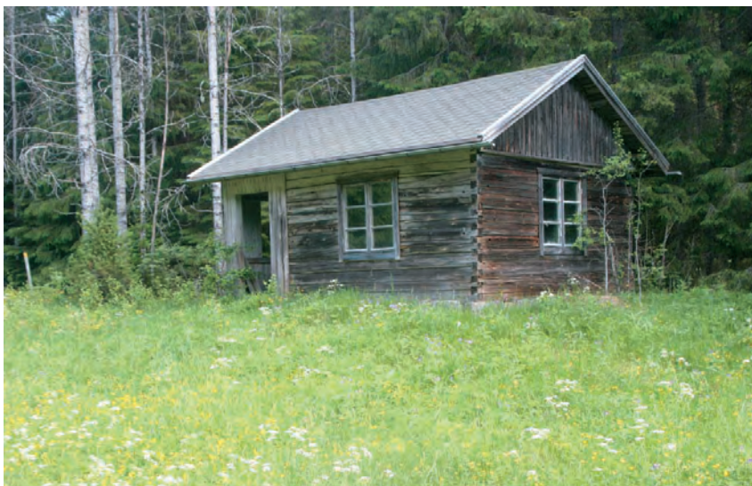
Stugan där Gunnar, Ernst, och Uno bodde sommaren 1916 (se sida 25). Skorstenen och spisen är borta, taket och fönstren är nya. Foto Anders Rhodin, 2007.
